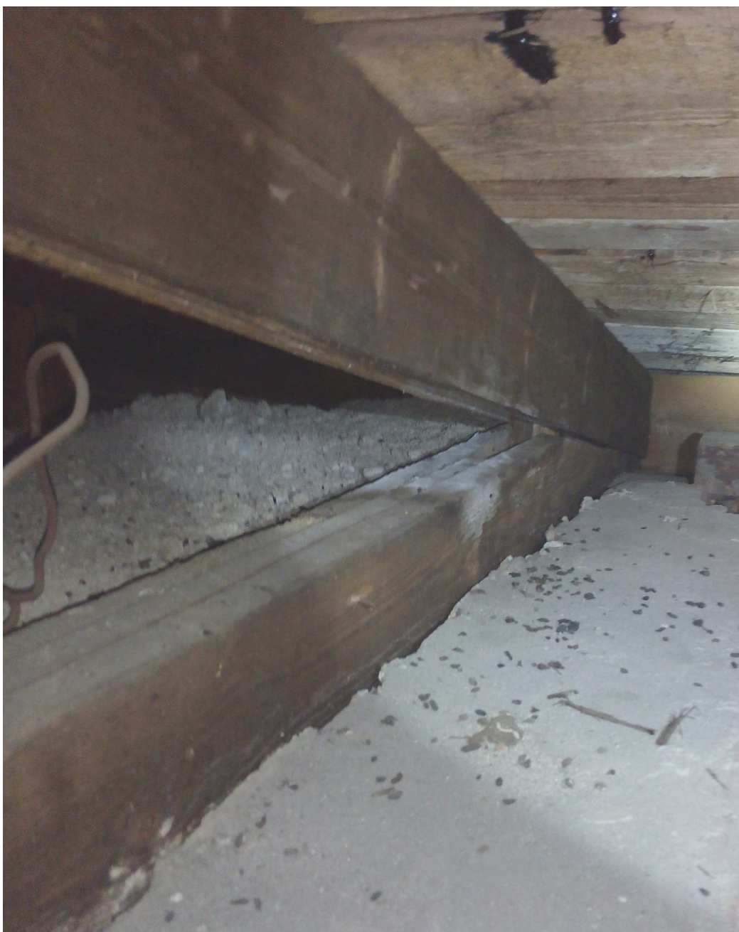
Fot. 3. Fragment więzara dachowego kratowego w miejscu oparcia – widoczne ślady zawilgocenia powstałe poprzez nieszczelność pokrycia dachowego.
