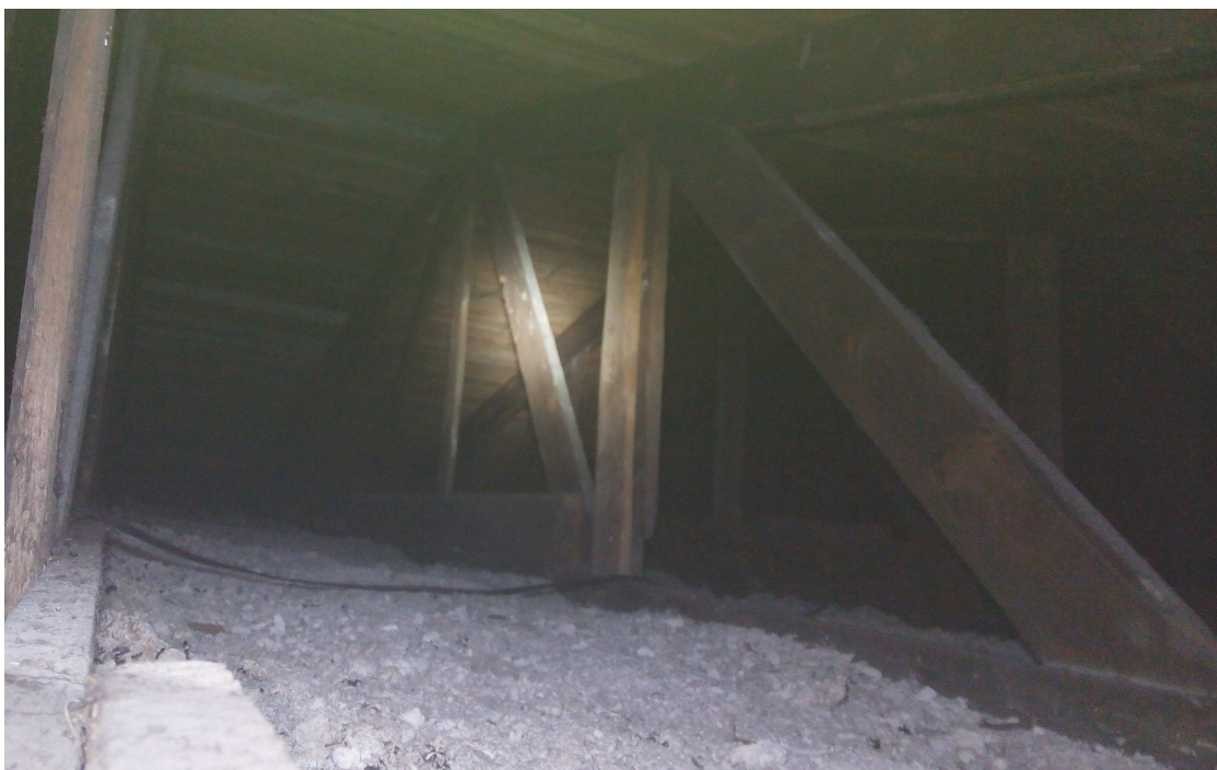
Fot. 1. Fragment więzara kratowego deskowego widoczny z poziomu strychu.
